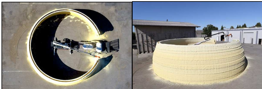
7. ábra. Az MIT berendezés munka közben felül- és oldalnézetben
