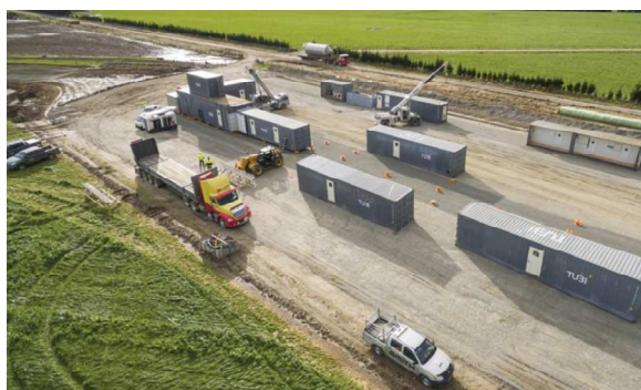
3. ábra. A Tubi mobil csőgyárat éppen konténermodulokból építik valahol Ausztráliában
