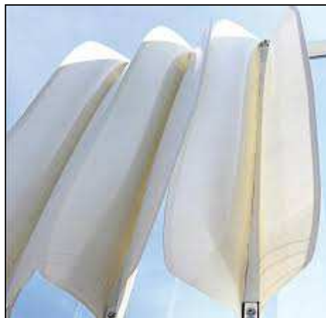
6. ábra Zárt (balra) és nyitott (jobbra) Flectofin árnyékoló elem a valóságban
