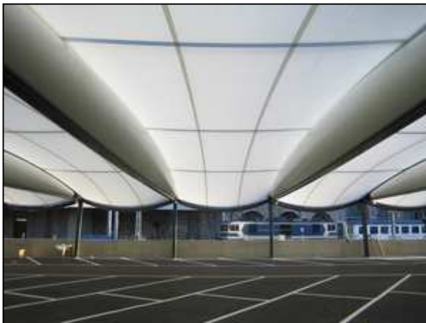
2. ábra A montreauxi garázs pillekőnyű teteje, amelyet öngyógyító pneumatikus gerendák tartanak
