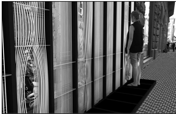
11. ábra Üvegszálak tartalmozó, nyomásra érzékeny panelek, amelyek az előtte álló mozgásától függően nyitják meg vagy zárják el a kilátást
