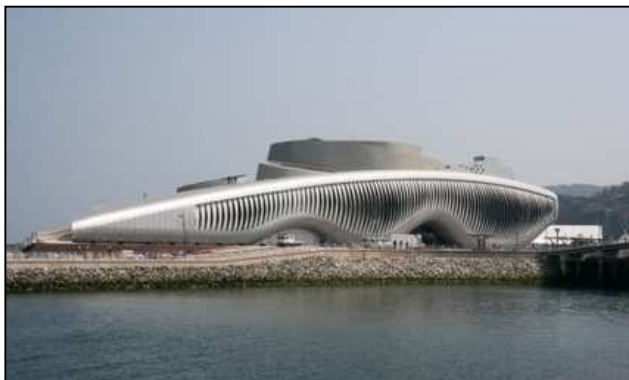
4. ábra A 2012-es dél-koreai Expo One Ocean pavilonja (balra) és a homlokzatát védő biometrikus Flectofin napárnyékoló rendszer kinagyított képe (jobbra)
