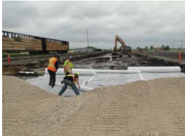
4. ábra. A gyenge, mocsaras altalajokon való használatra kifejlesztett Swamp Grid™ kompozit georács.
