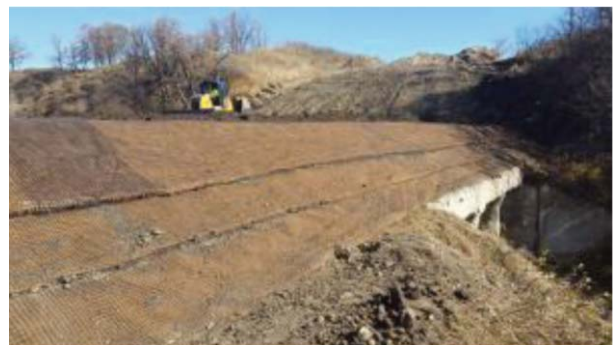
6. ábra. A kifejezetten támfalak és lejtős területek megerősítésére tervezett Pyramid Grid™ georács.
