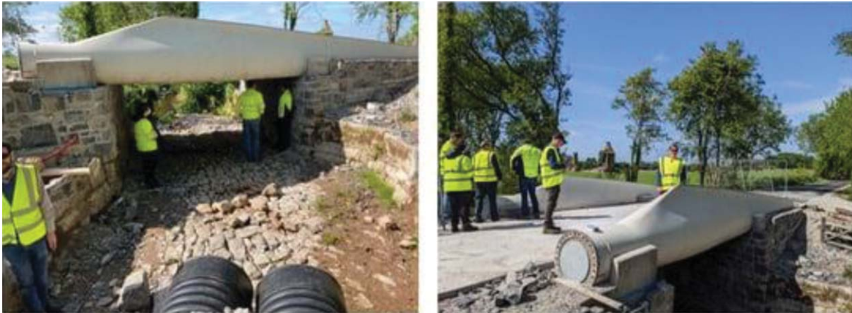
3. ábra. Elhasznált üvegszálerősítésű FRP szélturbina lapátokból kialakított gyaloghíd.
