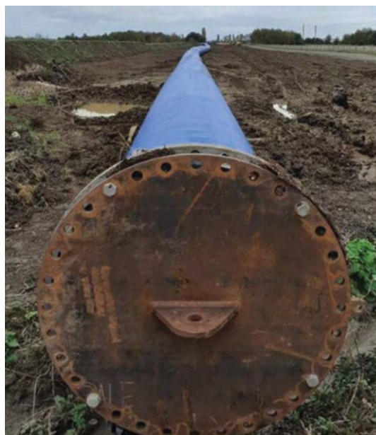
2. ábra. 1200 mm átmérőjű PE100 cső, amely egy korábbi, szálerősítésű (GRP) csövet vált fel.
