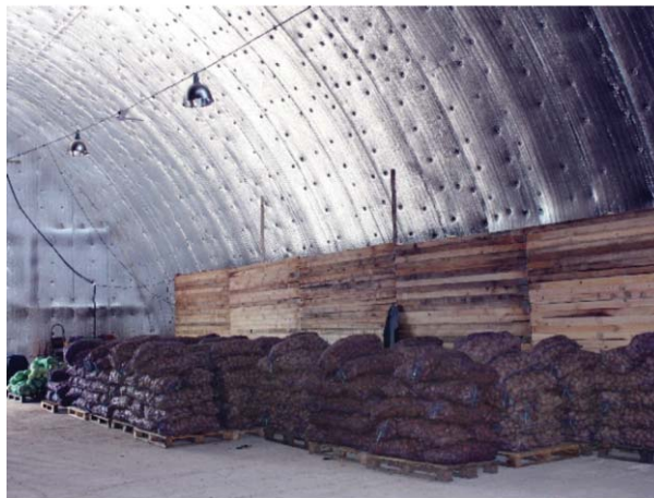
2. ábra. Raktárszigetelés végtelenített többrétegű polietilén habfólia rendszerrel.
