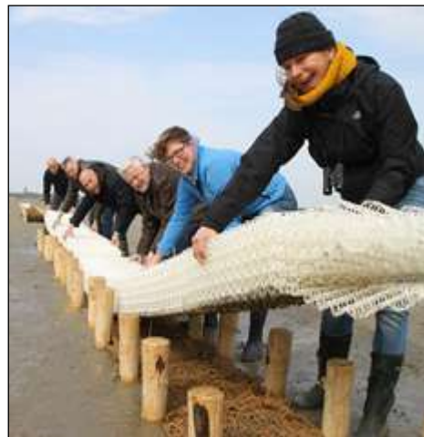
6. ábra Vízben lebomló kagylónevelő rácsok telepítése a tengerbe
