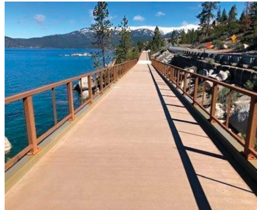
5. ábra. Közös használatú út – a Composite Advantage FRP FiberSPAN rendszerének alkalmazásával épült. (Forrás: Composite Advantage.)
