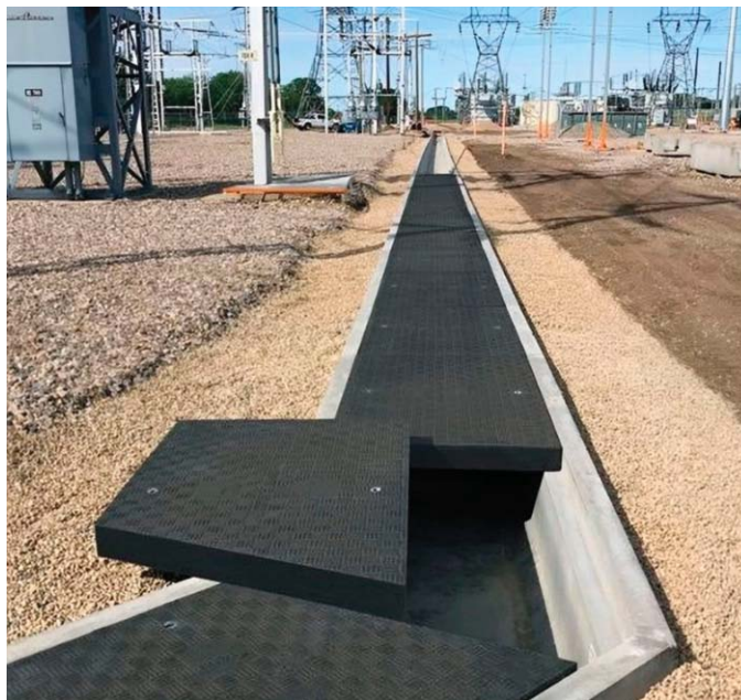
2. ábra. A kompozit fedőburkolatok számos előnyt kínálnak, beleértve a kisebb súlyt, a korrózióállóságot és a csúszásgátló mintázatot, amelyek biztonságos járási felületet biztosítanak. (Forrás: Fibrelite.)
