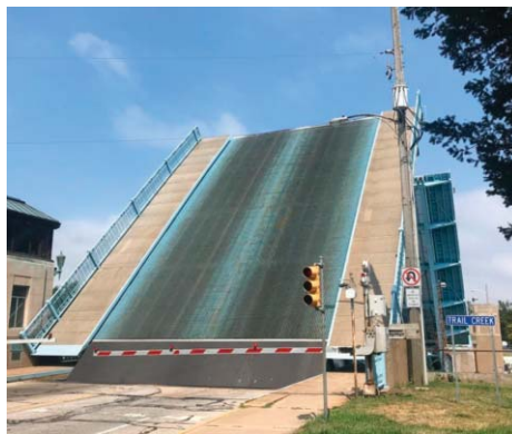
4. ábra. A Composite Advantage szálerősítésű polimer (FRP) FiberSPAN rendszere egy híd felújításnál. (Forrás: Composite Advantage.)
