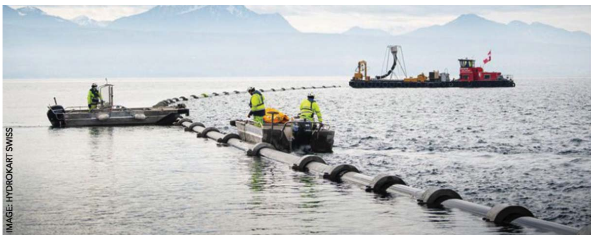
5. ábra. A Genfi-tavon úsztatással vitték el az előre összeállított csőrendszert a lesüllyesztés helyére.
