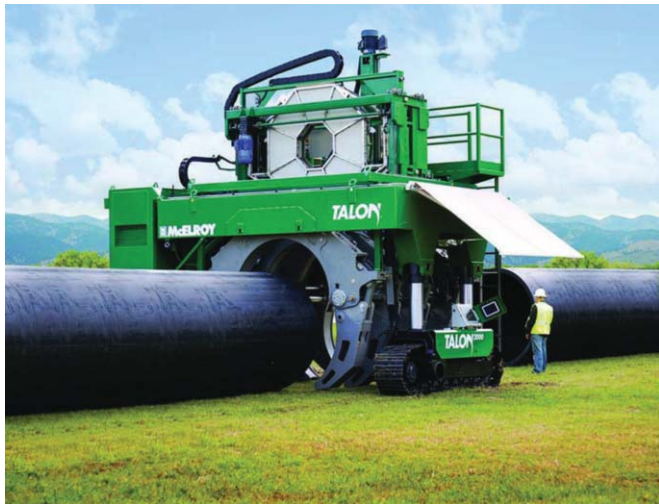
4. ábra. A McElroy cég Talon 2000-es fúziós gépe munka közben.
