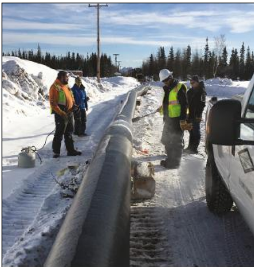
3. ábra Pipeline Plastics PEHD csövek ivóvíz szállítására az Északi-sarkon
