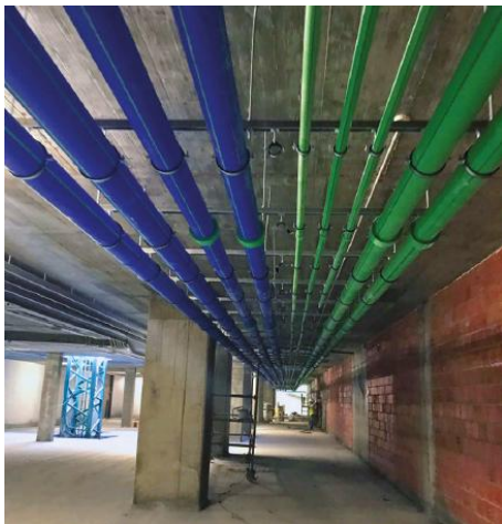
1. ábra Aquatherm csövek az ivóvíz elosztására (zöld) és a légkondicionáló rendszerhez (kék)
