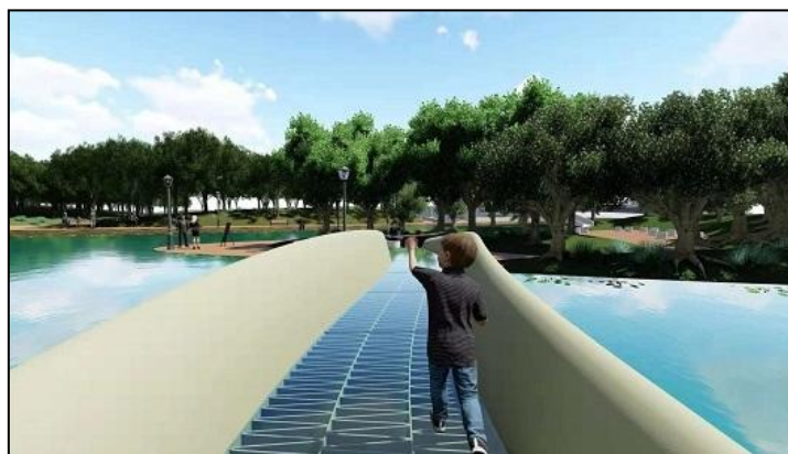
1. ábra 3D nyomtatással készített gyalogos híd Sanghajban
