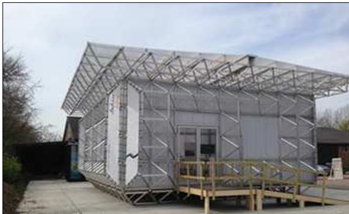
1. ábra A Sabic cég energiahatékony Lexan polikarbonátlapokból 3 nap alatt felépíthető „jégháza”
