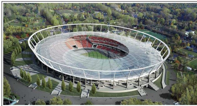
11. ábra A Slaski futballstadion alátámasztás nélküli átlátszó Thermoclear tetője
