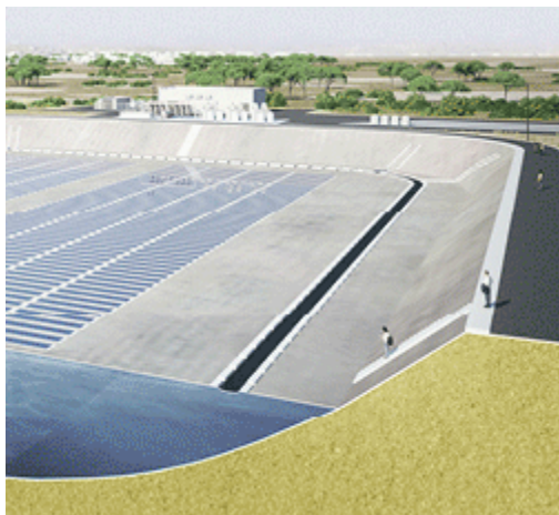
1. ábra PVC lemezzel borított és napelemekkel felszerelt víztározó Izraelben
