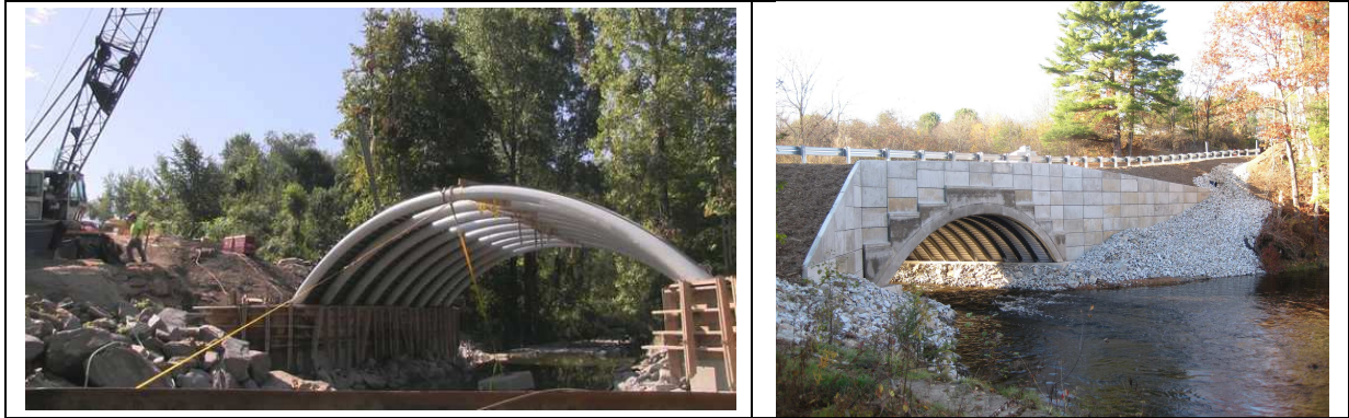
4. ábra Egy összeomlott híd pótlása a maine-i egyetem technológiájával. Bal oldali kép: építés közben; jobb oldali kép: a kész híd.
