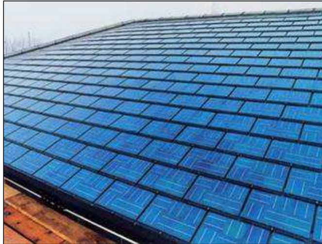
6. ábra Napzsindellyel fedett tető
