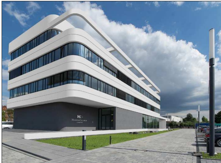
3. ábra A HessenChemie Wiesbadenben 2014-ben Plexiglas Mineral lapokkal burkolt épülete, a Munkaadók Szövetségének háza
