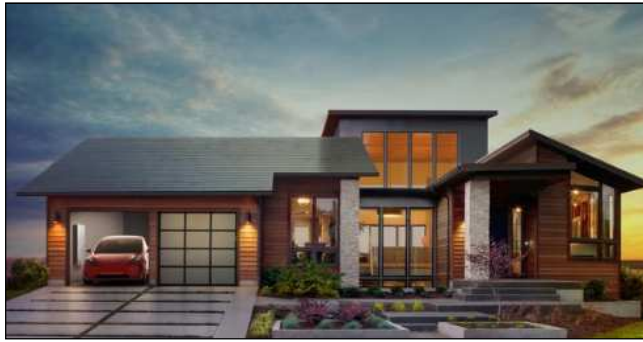
8. ábra A SolarCity rejtett napelemait tartalmazó cserepekkel fedett épület
